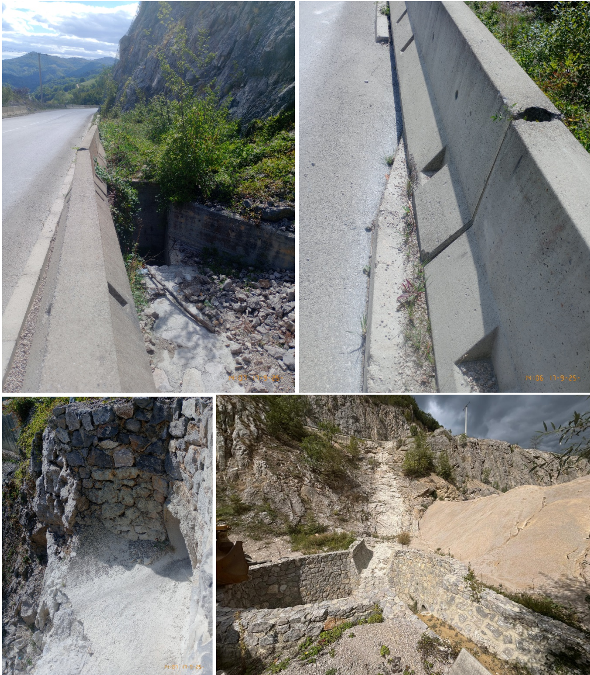
Слика 83: Приказ постојећег пропуста (Пропуст 1) који одводи воде са супротне стране државног пута и са самог пута у сабирни таложни шахт 1 регулације Рашчићке реке (септембар 2025. године)
