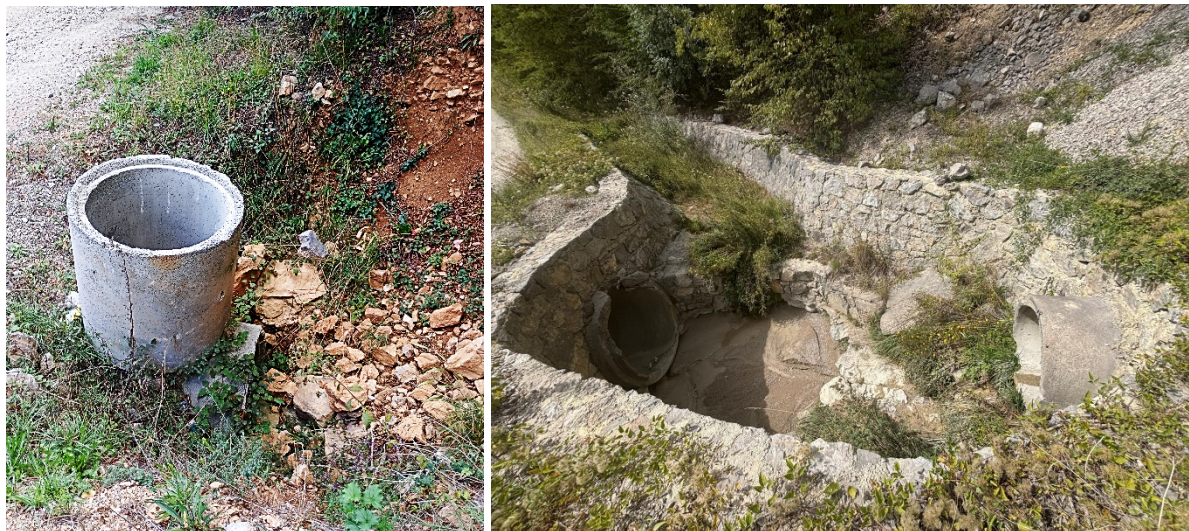
Слика 84: Приказ постојећег пропуста и канала за Воде пропуста 2 који одводи воде са супротне стране државног пута у сабирни таложни шахт 2 регулације Рашчићке реке (септембар 2025. године)
